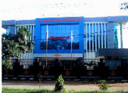
P.T. Dein Prima Generator JL. Raya Bekasi Km. 28, Medan Satria, Bekasi 17132 Jawa Barat, Indonesia
